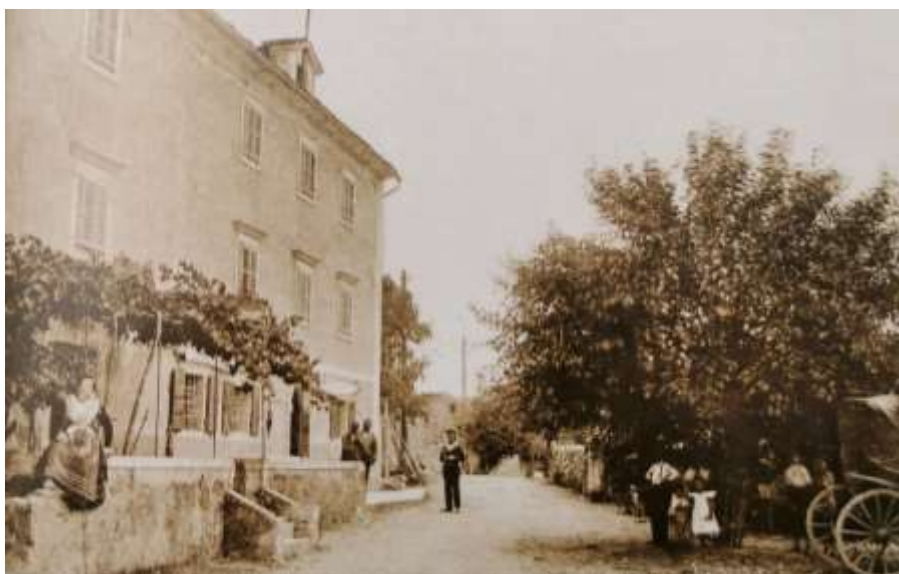
Slika 4. Prvi smještajno – ugostiteljski objekt Al cacciatore
