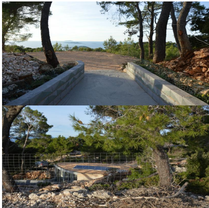
Slika 14. Prikaz recepcije sa solarnim panelima i terasom
