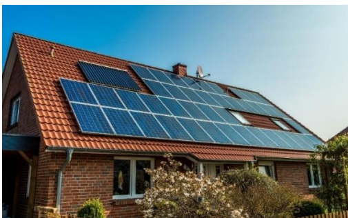
Slika 1: Kuća sa sunčevim kolektorom
