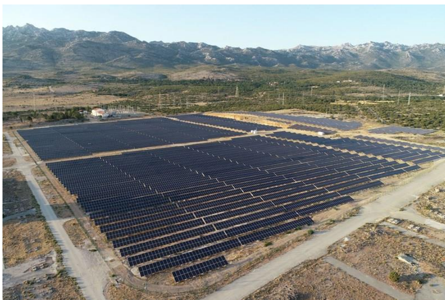
Fotografija 1: Sunčana elektrana Obrovac
