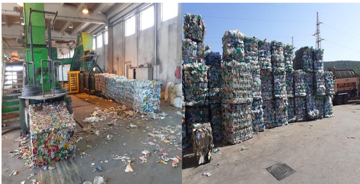
Slika 11. Otočna balirka i obrađene sirovine iz odvojeno prikupljenog otočnog otpada na lokaciji Treskavac
