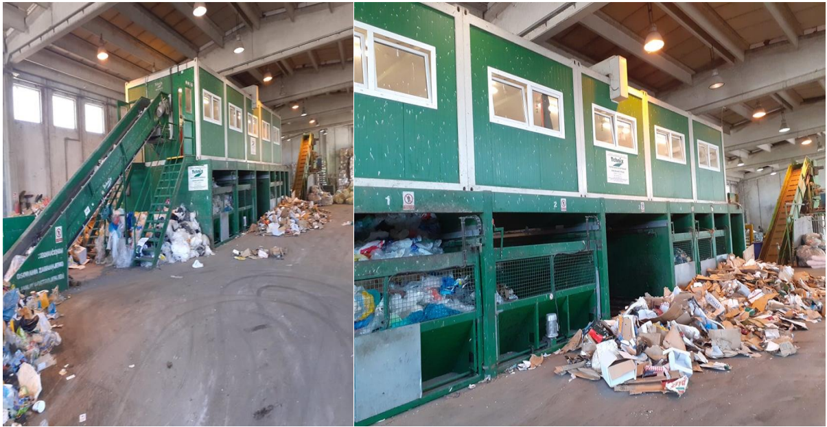
Slika 10. Otočna sortirnica na lokaciji Treskavac
