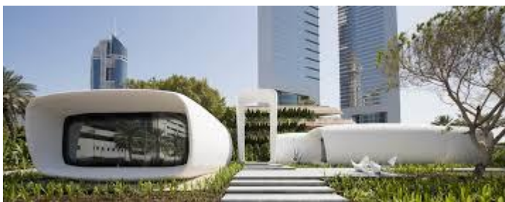
Slika 6: Office of the future / Ured budućnosti – prva zgrada napravljena 3D printerom
